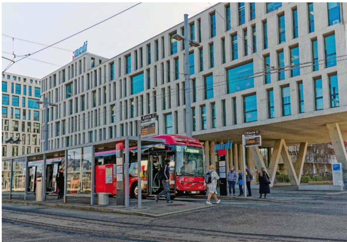
La gare de Wankdorf à Berne: un exemple pour une interface multimodale.
