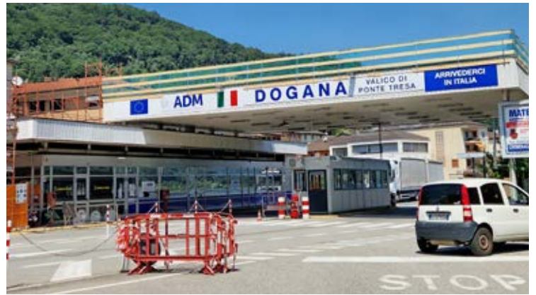
Vue du pont marquant la frontière.
